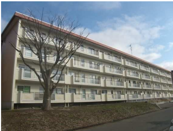
県営松崎住宅8号棟外壁改修工事
