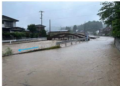
内川川氾濫状況(湯ノ又地区)
