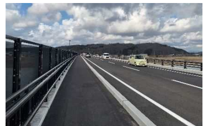
現在の水沢橋の状況
