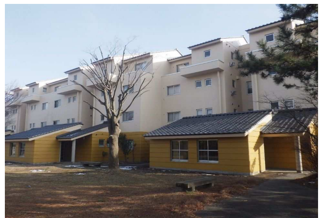
県営土崎港住宅2号棟外壁・屋根防水改修工事
