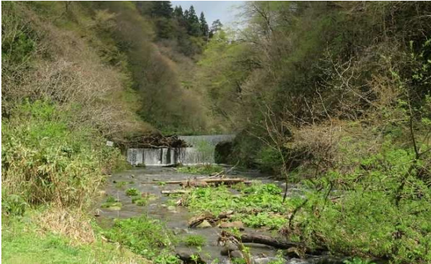
通常砂防工事
