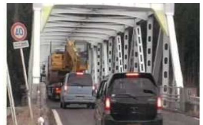
旧道の水沢橋の状況
