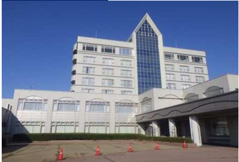
大湯スポーツ宿泊センター外壁改修工事 (大湯村)
