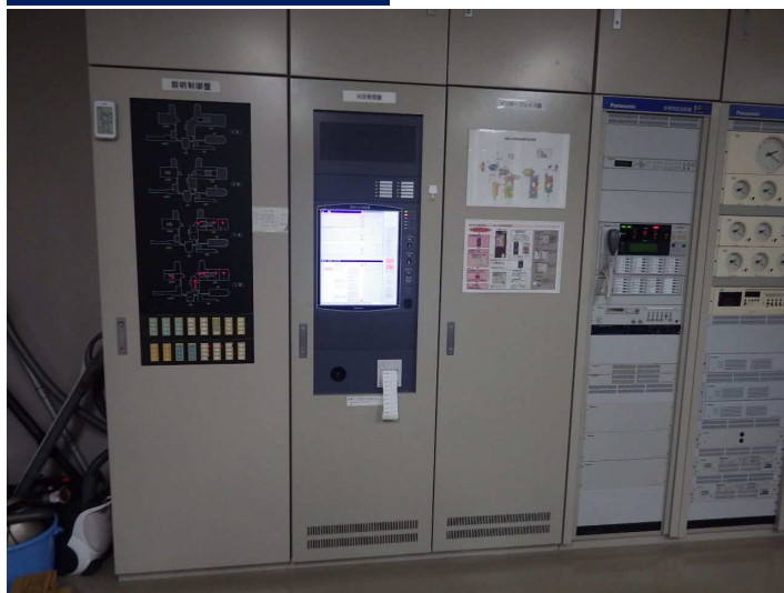
自治研修所・総合教育センター火災受信機ほか改修工事 (湯上市天王)
